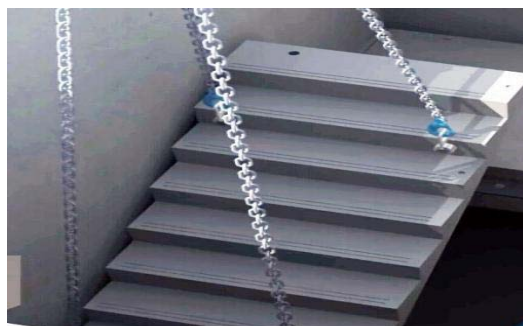
图1 预制楼梯吊运
