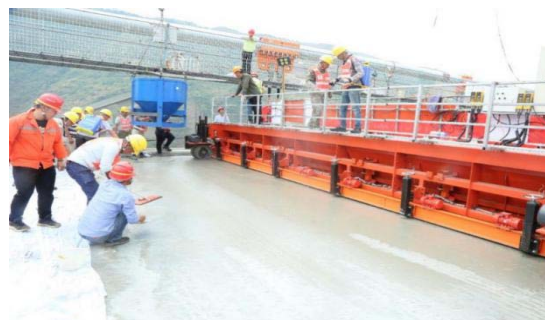
图3 UHPC入仓浇筑
