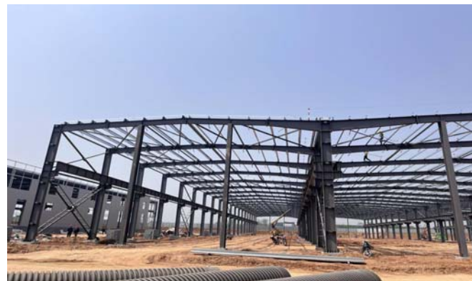
图1 钢结构厂房建筑结构
